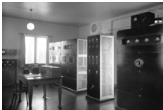
Interiör från sändarrummet i den gamla stationen.
