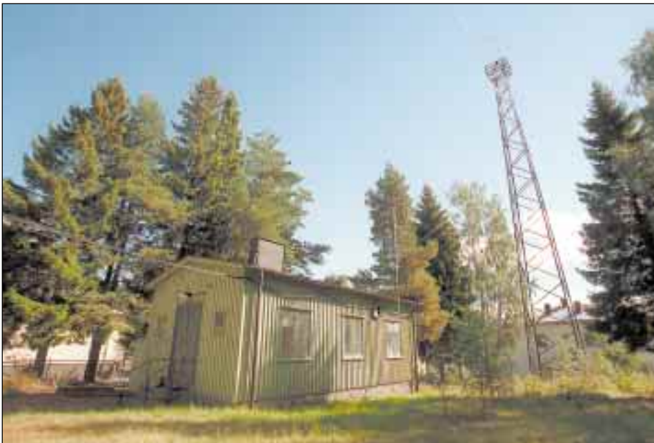
Radiostationen i Hudiksvall byggdes på trettioalet och finns fortfarande kvar. Det har väckts förslag om att byggnadsminnesförklara radiohuset och tillhörande masterna. Foto: Stefan Westerlund.
